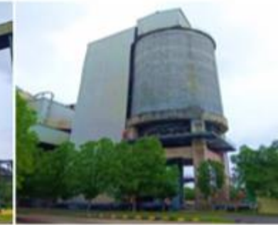
Fly ash Silo
